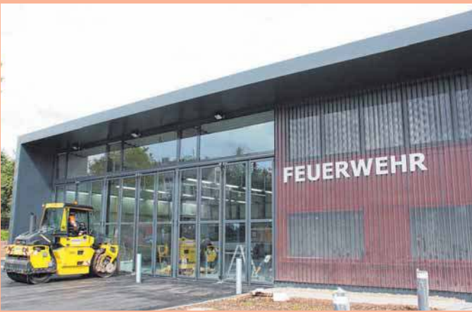
Letzten Freitag wurden die Zufahrten asphaltiert.
