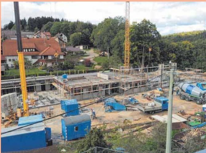
Vom Rathaus aus hat Bürgermeister Thomas Leibinger den Baufortschritt des Gebäudes im Bild festgehalten.
