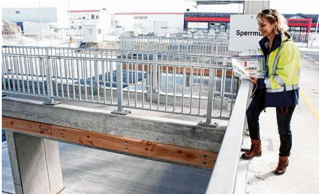
„Von dieser Abladerampe kann der Abfall von oben über eine Brüstung in die Container entsorgt werden, die ebenerdig platziert sind“, erklärt Heike Urbatsch. Das ist angenehmer und sicherer für die Kunden. BILDER: ROSSNER
