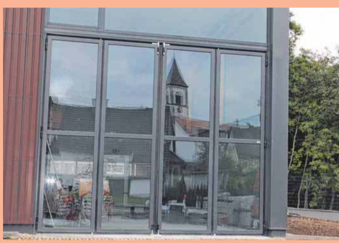
Die moderne Waschhalle wird sowohl der Feuerwehr als auch dem Bauhof zur Verfügung stehen.
