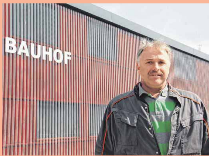
Im neuen Bauhof wird das Arbeiten für Fronmeister Stefan Grimm und seine Mitarbeiter wesentlich entspannter sein.
